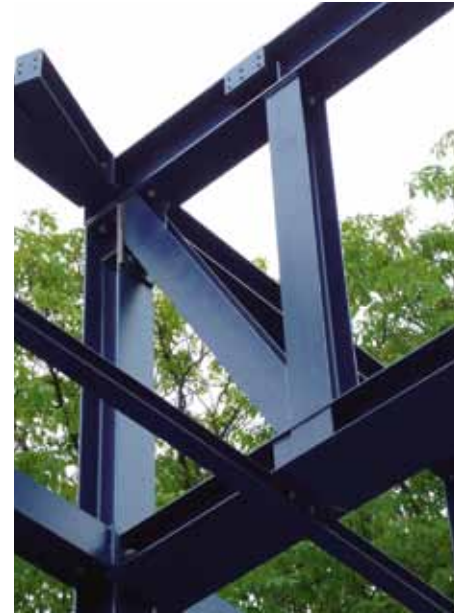
In de lierenkamer zijn slechts beperkt kolommen en diagonalen mogelijk.
