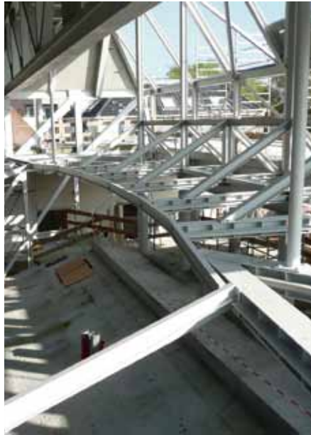
Staalconstructie voor het uitkragend balkon.
